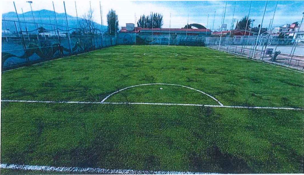
VI.- Rehabilitación de la cancha de fútbol "6" Unidad Deportiva Emiliano Zapata. Nivelación de superficie, colocación de alfombra sintética, caucho, arena sílica, malla perimetral metálica perimetral.
