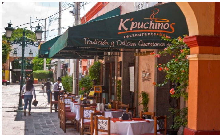
Calle de Tequisquiapan que conserva el ritmo de puertas y ventanas con cornisamento y rejas. Se aprecian alteraciones. Se ejemplifica casa con patio adaptada para restaurante
