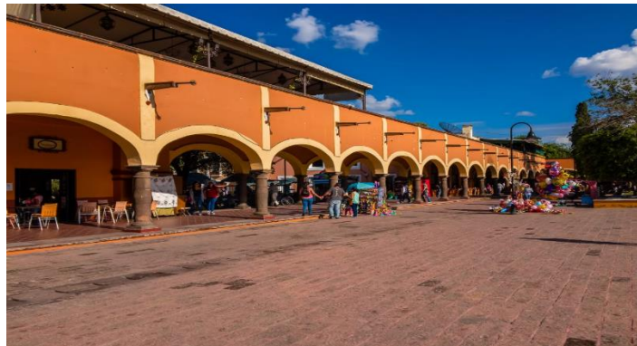
Vistas de los portales, arquera y adintelamiento; terrazas sin reglamentación en el segundo nivel. En la esquina Morelos y niños Héroe el espacio de la plaza se fuga hacia la plazoleta.
